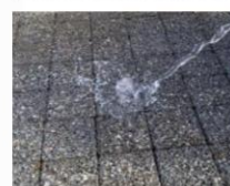
Pavés drainants, pose à joints vifs
